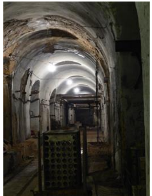
La gare d'échange à l'entrée de l'ouvrage et le magasin aux munitions (M1) avec ses 9 alvéoles
