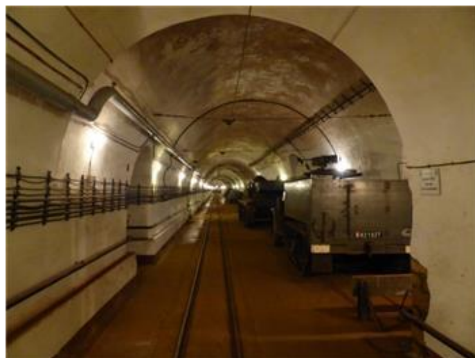
L'une des nombreuses galeries de l'ouvrage.
