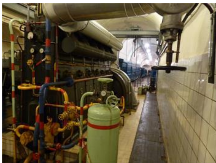
Une partie de l'usine électrique
