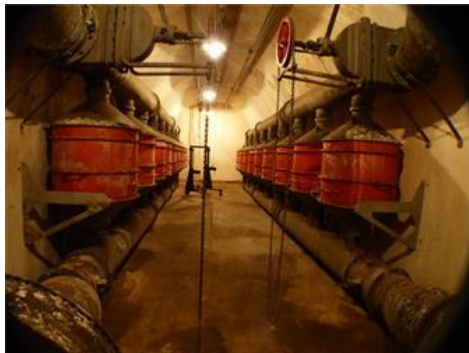
Equipement de cuisine ultra moderne en inox et aluminium, salle des filtres pour parer aux attaques aux gaz.
